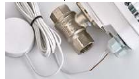
Фото 12. Завести провод датчика в кабельный ввод
