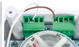
Фото 15. Подключение датчика к электроприводу
